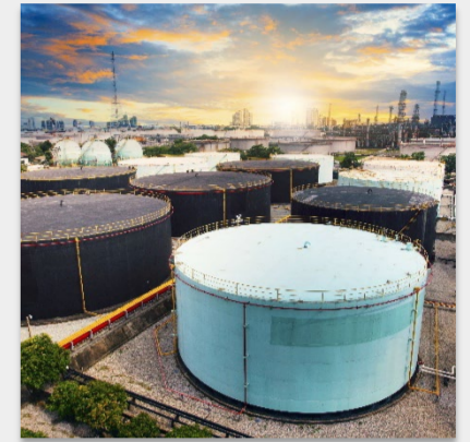
Monitoring von Industrieanlagen
