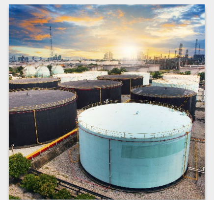
Monitoring von Industrieanlagen
